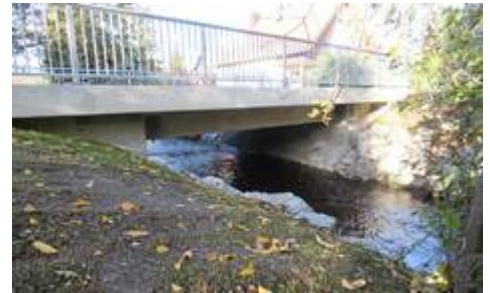
Gennachbrücke nach der Sanierung
