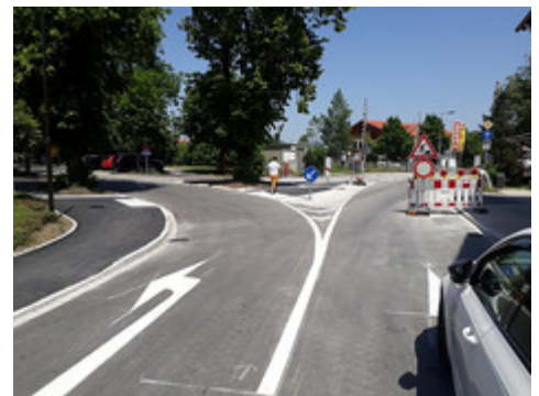
Fertiggestellter Bereich am Bahnübergang
