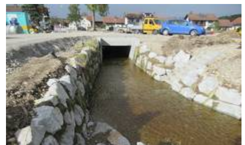
Lugenbachbrücke Süd mit Verbreiterung der Kreisstraße OAL 3
