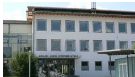
Der frisch sanierte Südflügel der Realschule Füssen
