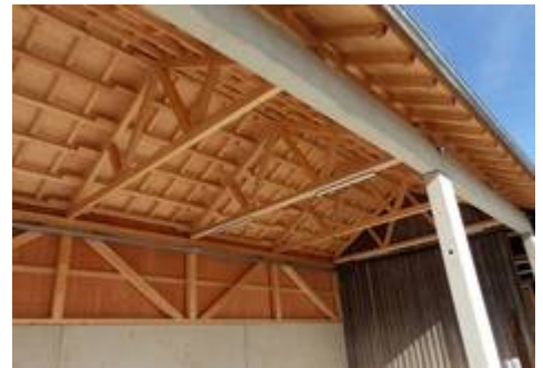
Dach der neuen Containerhalle am Wertstoffhof Buchloe
